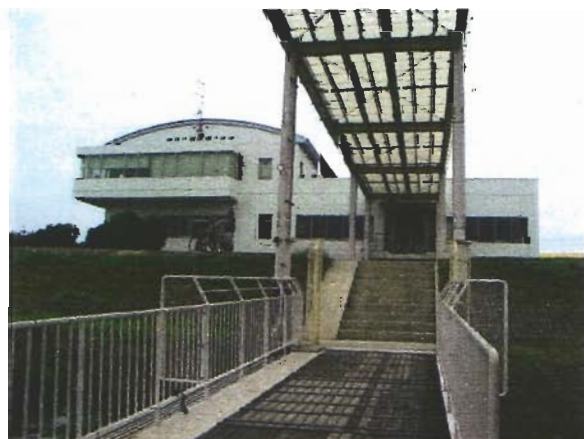
ポンツーンから整備棟を見る
