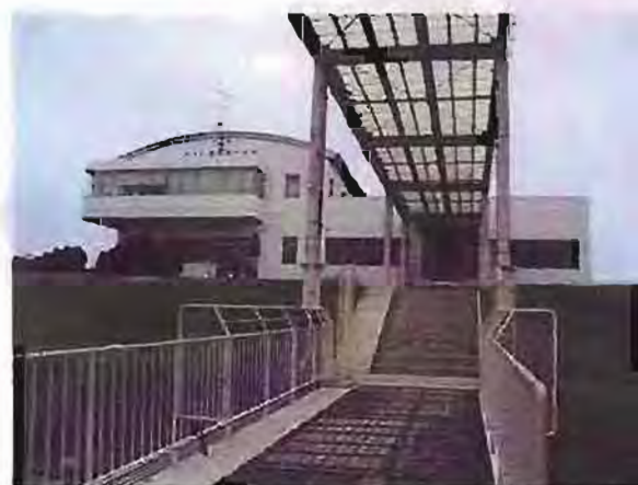
ポンツーンから整備棟を見る
